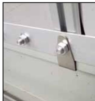
Crochet à positionner lors de la pose de la serre sur la base
