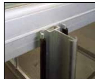
Fixation des profilés de vitrage 25002 sur la traverse haute 04003
