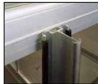
Fixation des profilés de vitrage 25002 sur la traverse haute 04003
