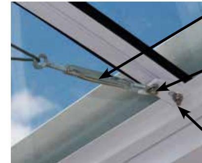
Tendeur à oeil pour réglage de tension du câble (35)
