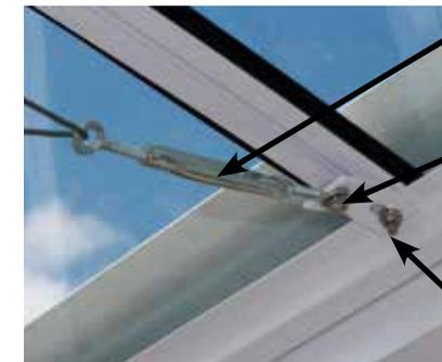
Tendeur à oeil pour réglage de tension du câble (31)
