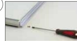
En cas d'utilisation des polycarbonates de 8 mm sur la lucarne, positionnez l'obturateur (59) sur la partie inférieure du panneau de polycarbonate.
