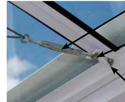
Tendeur à oeil pour réglage de tension du câble (33)
